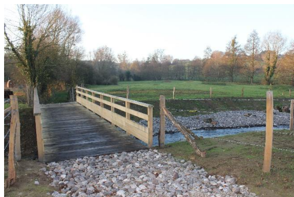
Nouvelle passerelle au moulin de Glinet
