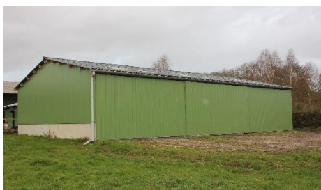
Nouveau bâtiment technique communal
