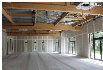
La salle en construction
