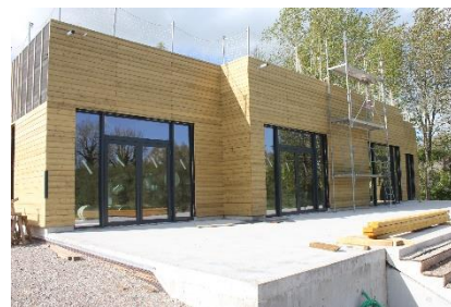
Un aperçu de la façade sud de la salle
