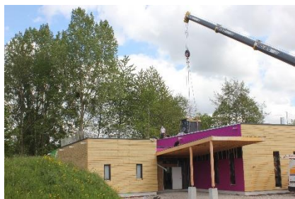
Une phase de travaux délicate... à la salle polyvalente
